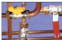
Entretien réseau et conduits
