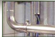
Maintenance des canalisations en milieu alimentaire
